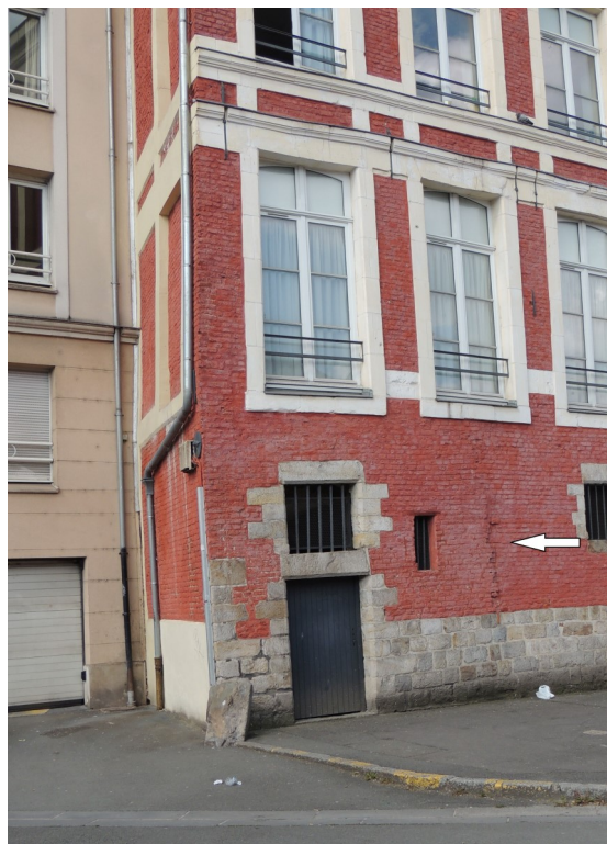
À droite du 21 avenue du Peuple-Belge, au pied de la rampe, le retrait d'alignement et la fissure indiquée par la flèche blanche donnent l'emplacement et la largeur du pont romain qui franchissait la Deûle à la façon sans doute de l'ex pont à trous de Tournai.
