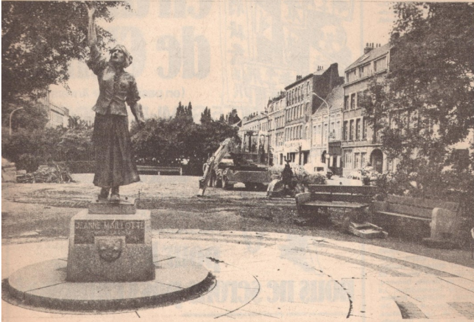
Quinze jours de travaux pour réaliser une nouvelle percée pour les autobus.
