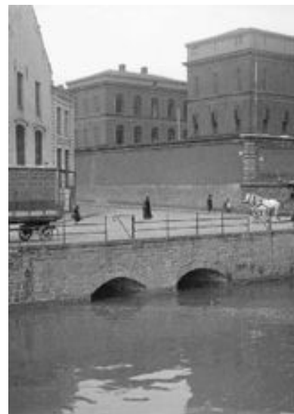
Les canaux intérieurs se déversaient dans la Basse-Deûle. Ici, le débouché du canal Saint-Pierre qui amenait les eaux du quai du Wault en passant par les canaux de la Baignerie, de Weppes et du Cirque (la Treille).
