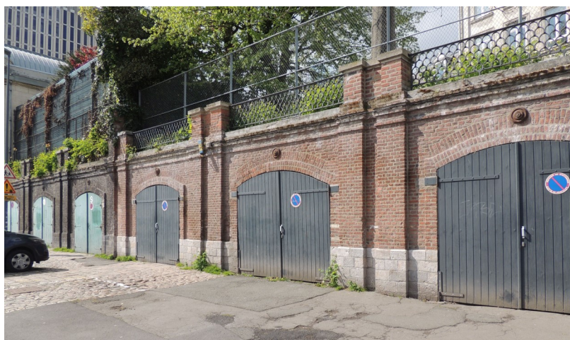
Ces garages situés entre le conservatoire et le Pont-Neuf sont un exemple des nombreux espaces qui pourraient devenir des cellules commerciales.
